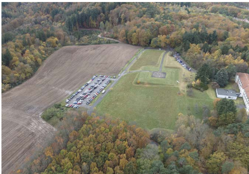
Drohnaufnahme aus östlicher Richtung mit Waldbestand bzw. bestehendem Waldrand und vorhandenem Hubschrauberlandeplatz sowie Parkplatz
