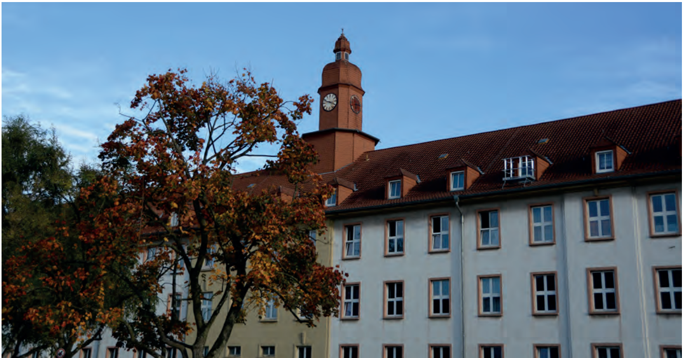
Erhaltenswerte Bausubstanz der ehem. Hoeferkaserne im Süden Erbachs mit Modernisierungs- und Instandsetzungsbedarf
