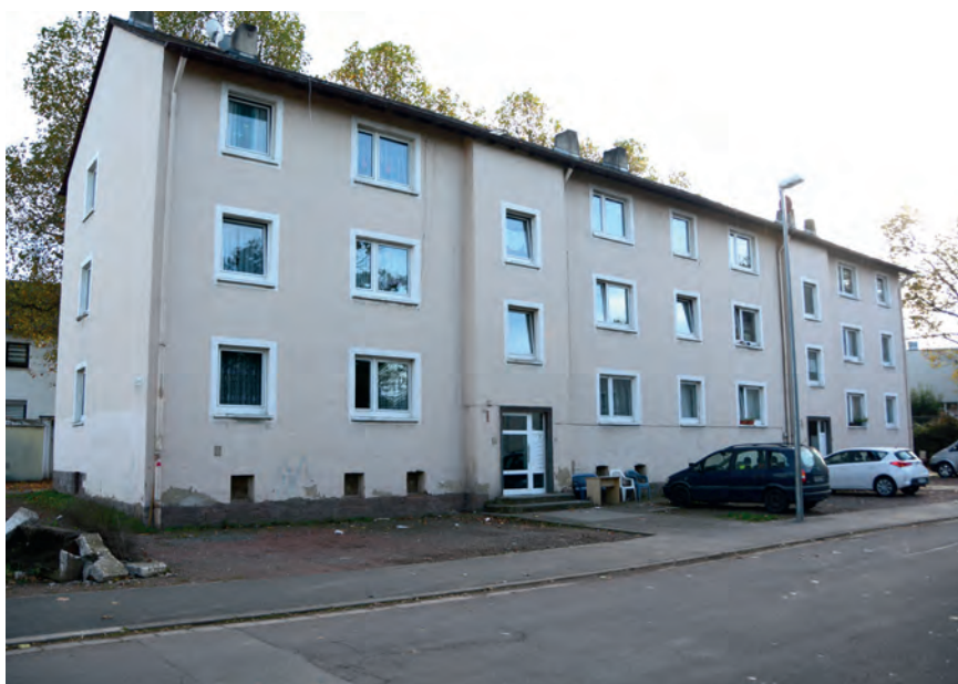
Sanierungsbedürftige Bausubstanz im Bereich der Böcklingstraße
