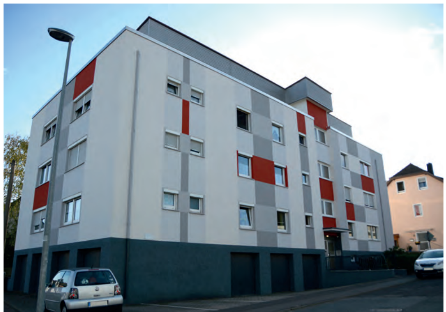
Modernes Gebäude innerhalb des Fördergebietes mit geringem Sanierungsbedarf
