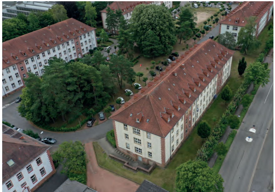
Schützenswerte Bausubstanzen der ehemaligen Hoeferkaserne im Süden Erbachs
