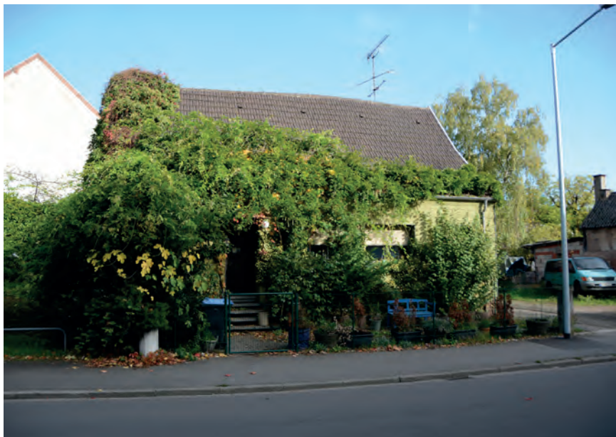
Sanierungsbedürftige Bausubstanz im Bereich der Steinbachstraße
