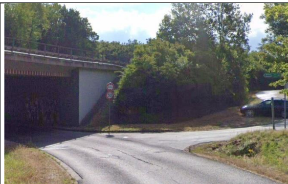
Abbildung 4-21: Unterführung an der Webenheimer Straße
