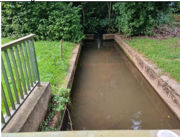
Abbildung 4-65: Sandfang am Zulauf des Seensystems
