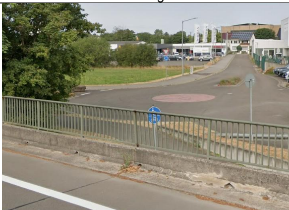
Abbildung 4-45: Unterführung am Radweg Höhe Mainzer Straße
