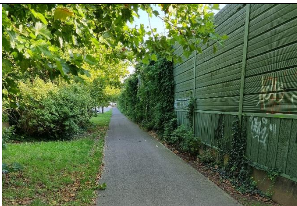
Abbildung 4-55: Lärmschutzmauer an der Zweibrücker Straße
