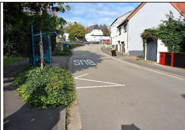
Abbildung 4-58: Lokale Geländesenke an der Dorfstraße Höhe Zwerchalmbach
