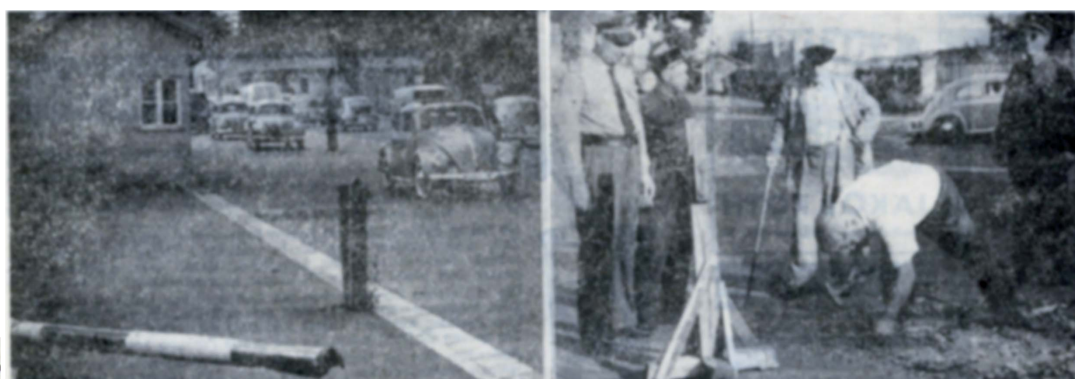
Der Schlagbaum ist gefallen. Ungehindert rollt der Verkehr am Kaplaneihof vorbei, der seit Mitternacht keine Grenzstation mehr ist. Am späten Samstagnachmittag haben auf der saarländischen Seite des bisherigen Grenzübergangs Kaplaneihof die ersten Arbeiten zum Abbau der Zollschranken begonnen. Ein Handwerker beseitigt den Auflagerpfosten für die Schlagklümmen. (Fotos: Presse-Photo-Aktuell und H. Gelner)
