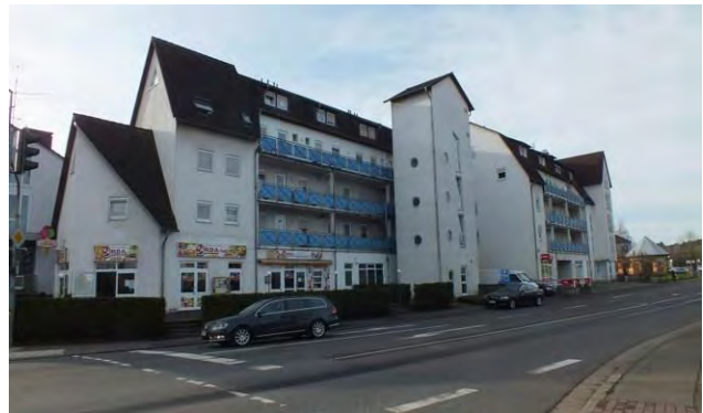
Ist-Zustand 2016, Blick von Nordosten (Fotos: isoplan)
