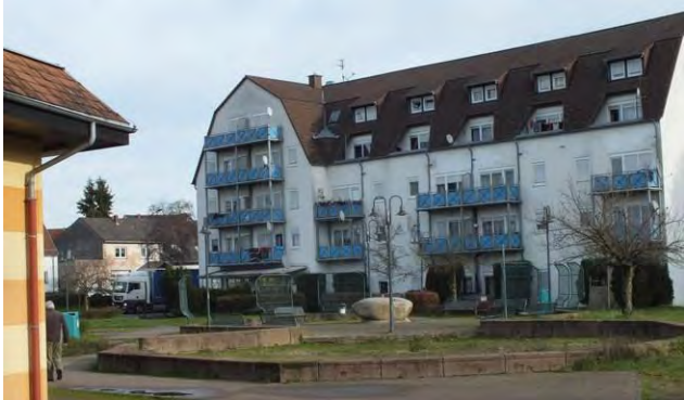
Ist-Zustand 2016, Blick vom Eduard-Vollmar-Platz
