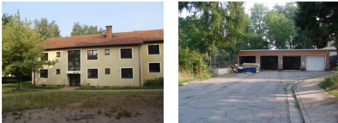
Abbildung 36: Gebäudeleerstände in der ehemaligen Landesaufnahmestelle Erbach
