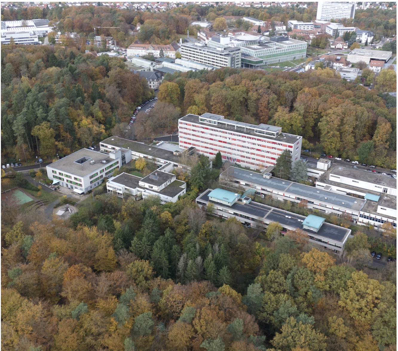
Drohnaufnahme aus südöstlicher Richtung (L 213) mit Blick auf Bestandsgebäude Nervenklinik und Waldbestand; im Hintergrund weitere Gebäude der Universitätsklinik des Saarlandes außerhalb des Geltungsbereiches des Bebauungsplanes
